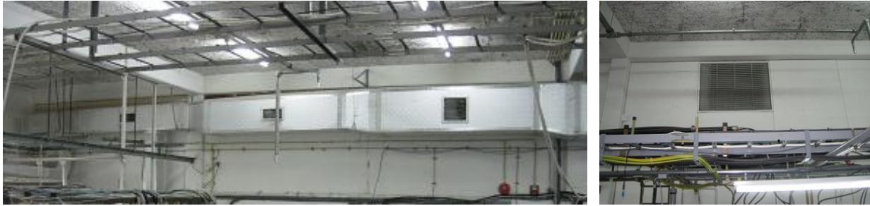
Figuur 15: Het luchtdistributiesysteem (links) en het rooster voor retour (rechts)
