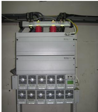
Figuur 18: Een 600 watt DC power plant (links) en de efficiëntie curve (rechts).
