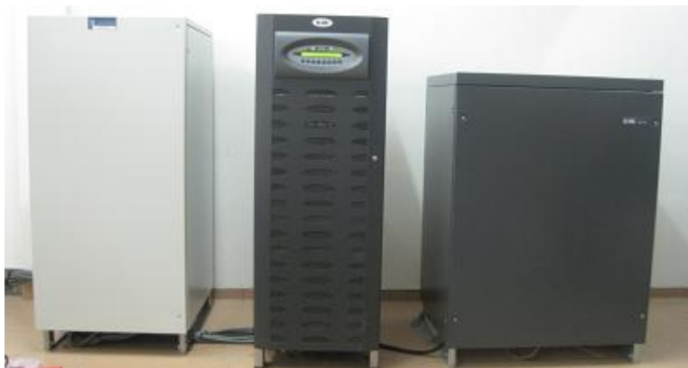
Figuur 19: Een monolithische UPS van 60kVA die op Centrum 2 staat
