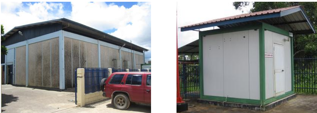
Figuur 14: Behuizingen van apparatuur en systemen bij Telesur
