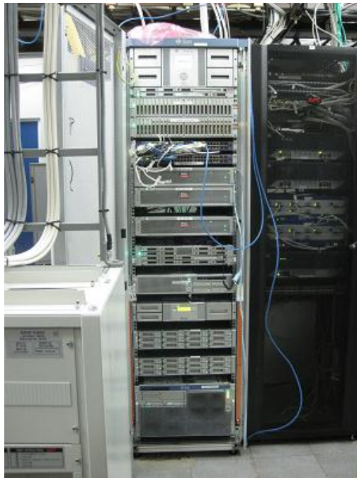
Figuur 21: Rekken met IT-apparatuur in een station bij Telesur
