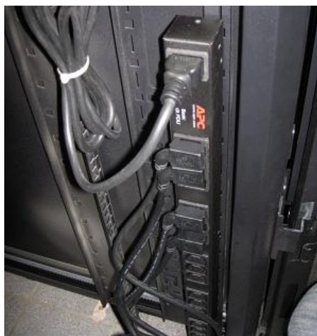
Figuur 23: Een APC basic rack PDU
